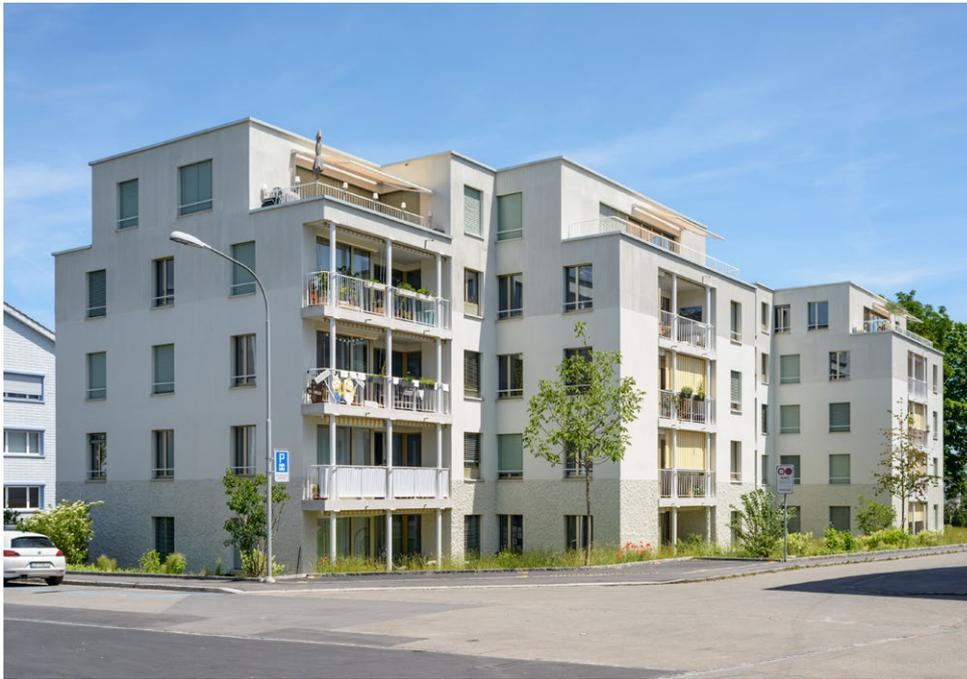
Der Ersatzneubau Rautihalde 15/19 der Stiftung PWG in Zürich-Altstetten wurde u. a. durch wärmedämmendes Einsteinauerwerk in kostengünstiger und ökologischer Bauweise errichtet und erhielt die Auszeichnung für gute Bauten der Stadt Zürich.
